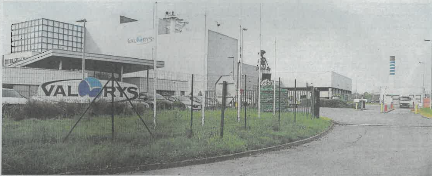
Le site de Valorys, à Pluzunet, traite notamment les déchets ménagers, ceux de la collecte de tri ou ceux infectieux, provenant du milieu médical.
